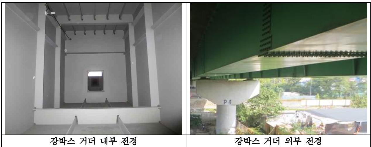
【사진 3.2.3】 강박스 거더 전경(대구)
