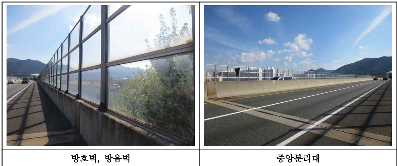
【사진 3.3.21】 난간 및 연석 전경(부산)
