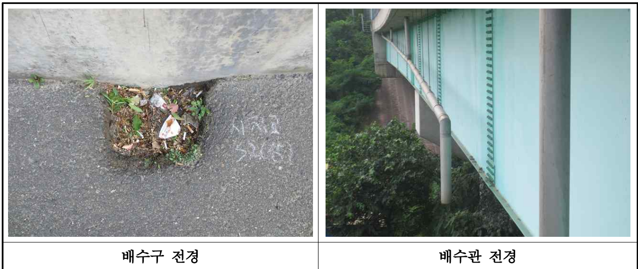
【사진 3.2.19】 배수구 및 배수관 전경(대구)
