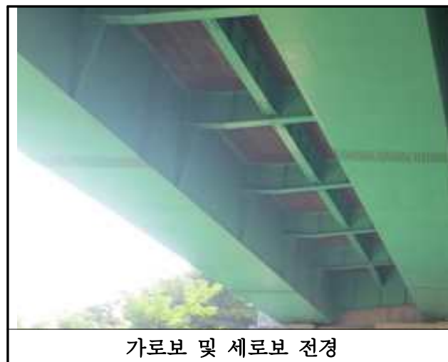
【사진 3.2.6】 가로보 및 세로보 전경(대구)
