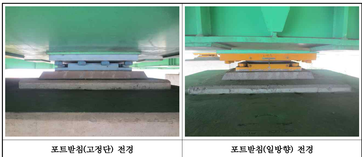
【사진 3.2.11】 교량받침 전경(대구)
