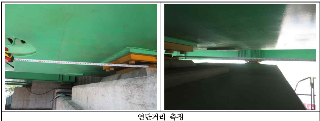
【사진 3.2.13】 연단거리 측정 전경(대구)
