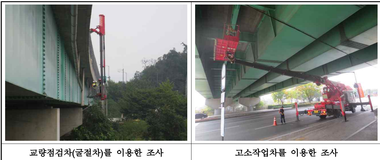
【사진 3.1.1】 근접 육안조사
