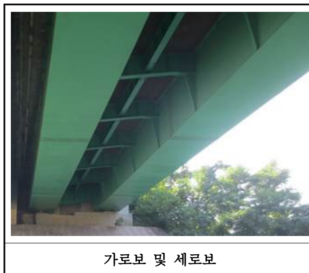
【사진 3.3.6】 가로보 및 세로보 전경(부산)
