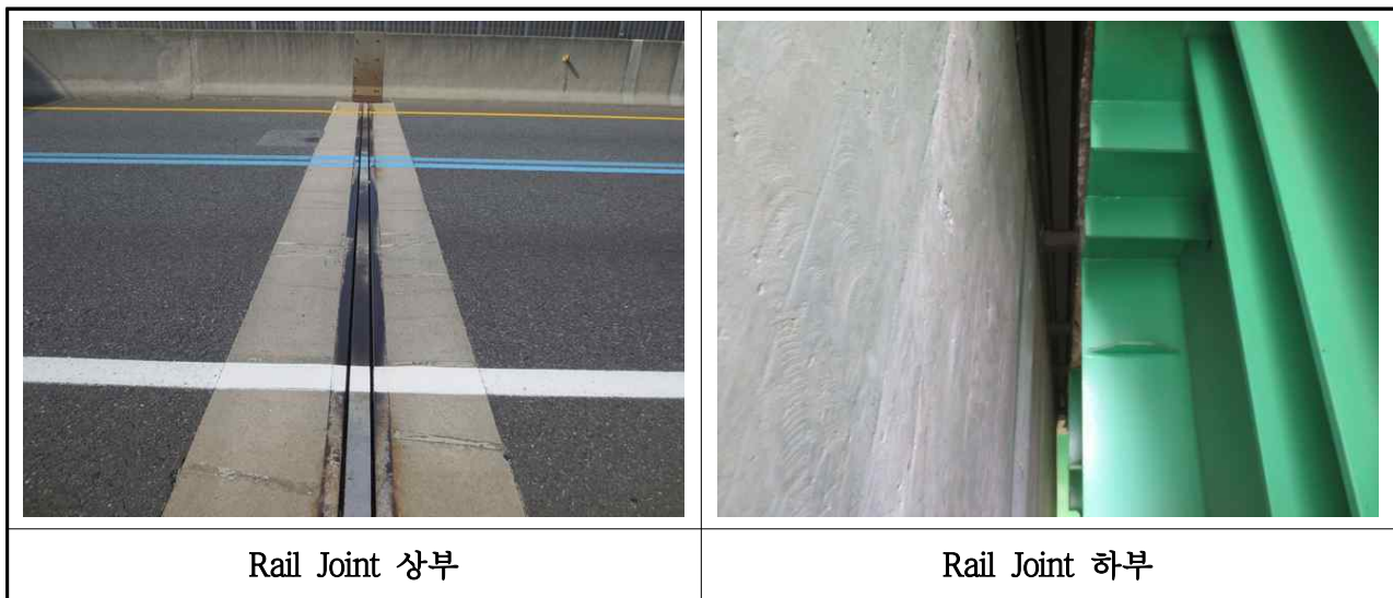
【사진 3.2.14】 신축이음장치 전경(대구)
