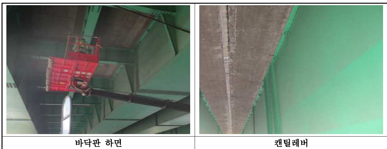
【사진 3.2.1】 바닥판 전경(대구)
