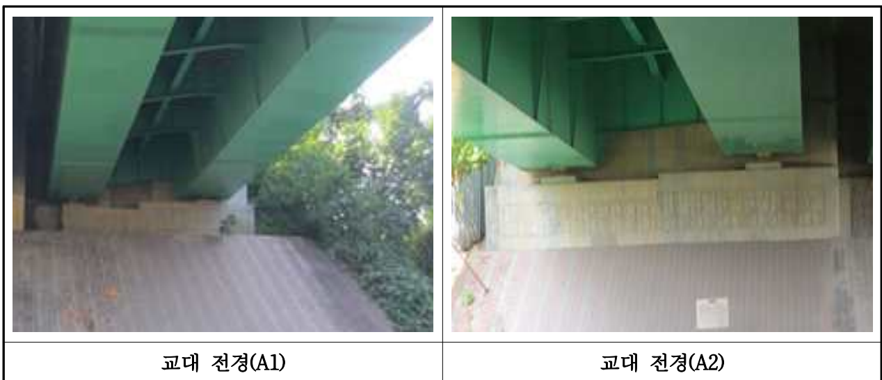
【사진 3.3.7】 교대 전경(부산)
