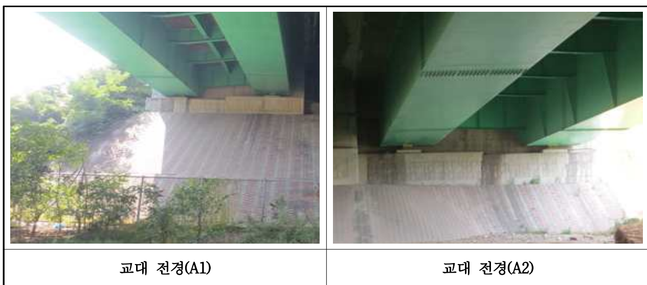
【사진 3.2.7】 교대 전경(대구)
