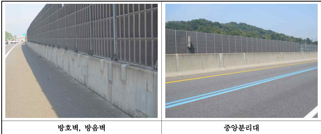
【사진 3.2.21】 난간 및 연석 전경(대구)
