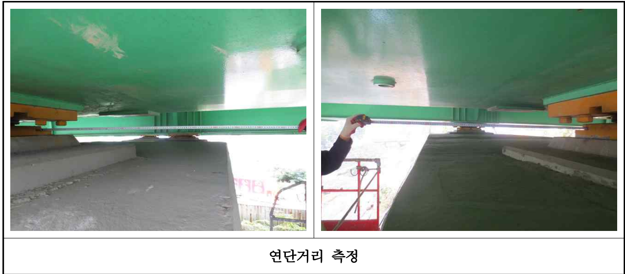
【사진 3.3.13】 연단거리 측정 전경(부산)
