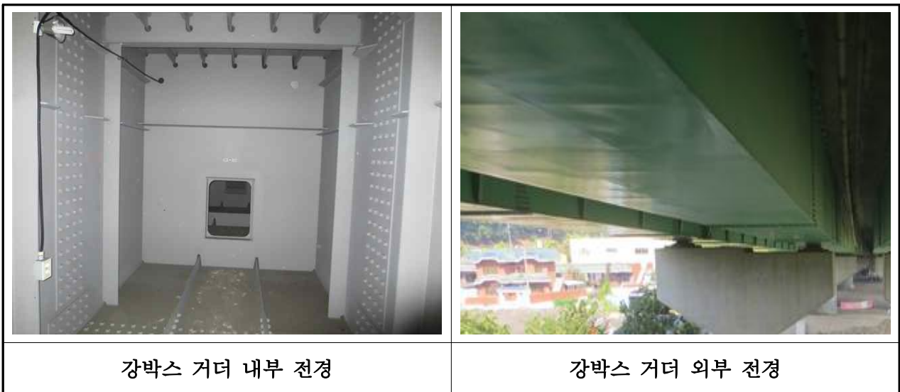
【사진 3.3.3】 강박스 거더 전경(부산)
