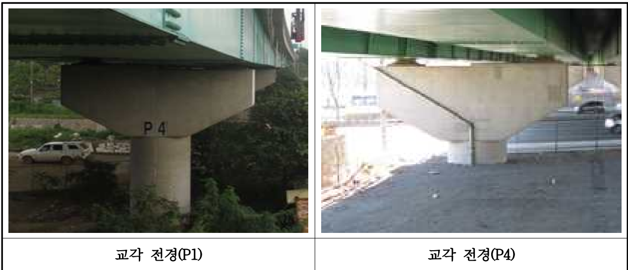
【사진 3.2.9】 교각 전경(대구)
